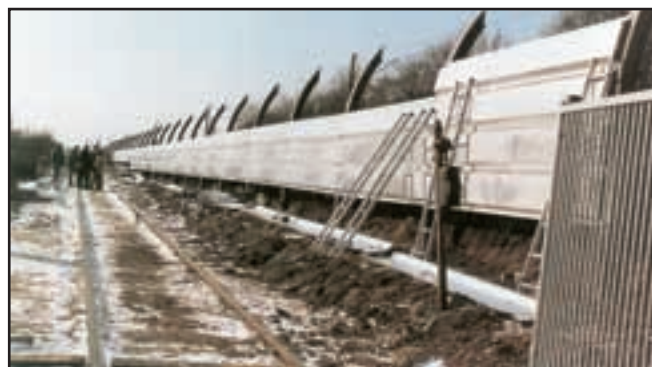
Varmforzinkede søjler og planker, der anvendes som værn mod støj fra togtrafik i tæt bebyggede områder
