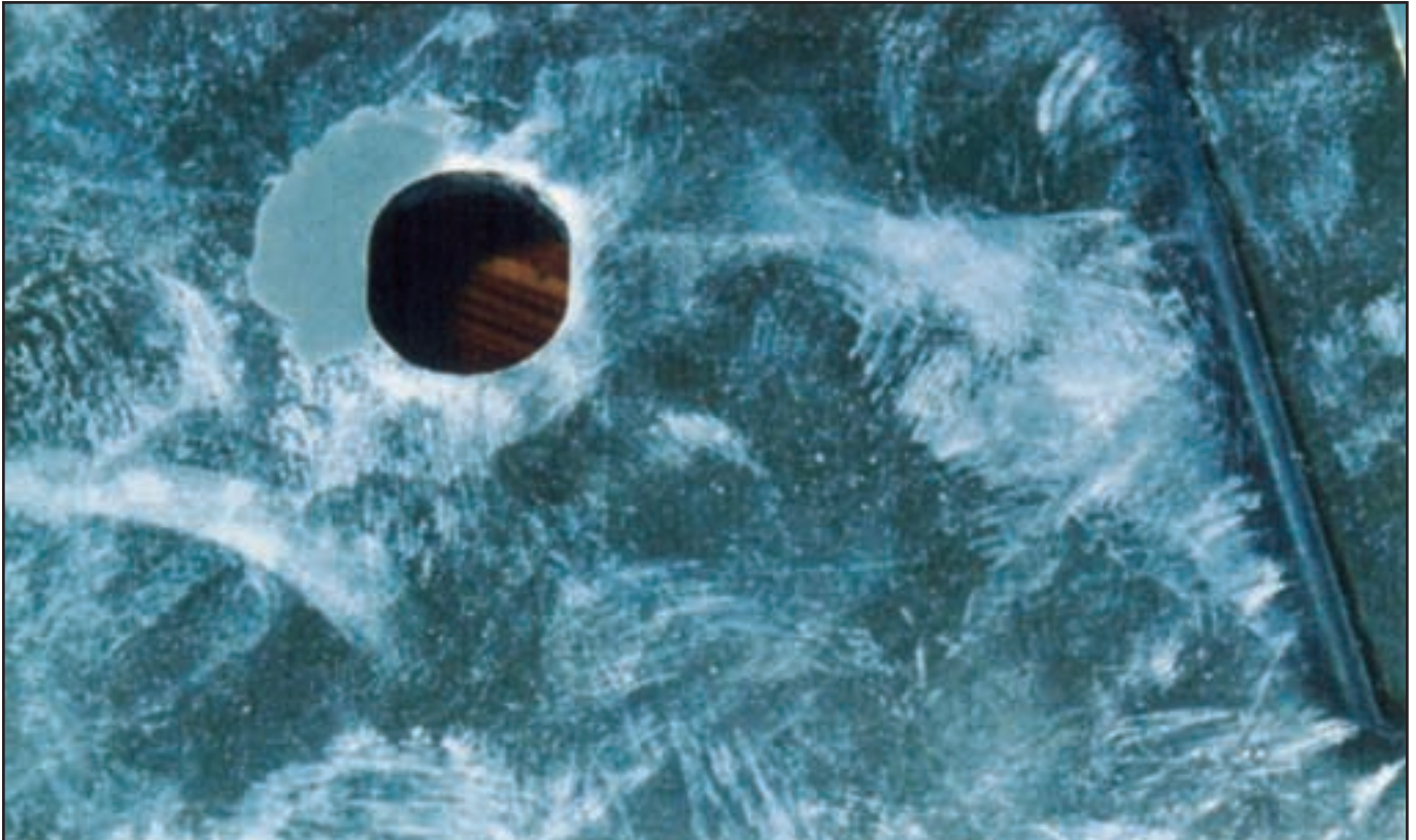
Eksempel på reparation af zinkafskalning omkring et udstanset hul i varmforzinket plade. Reparationen er udført med zinkstøvmaaling.
